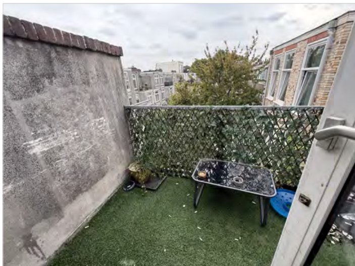
Balkon tweede verdieping
