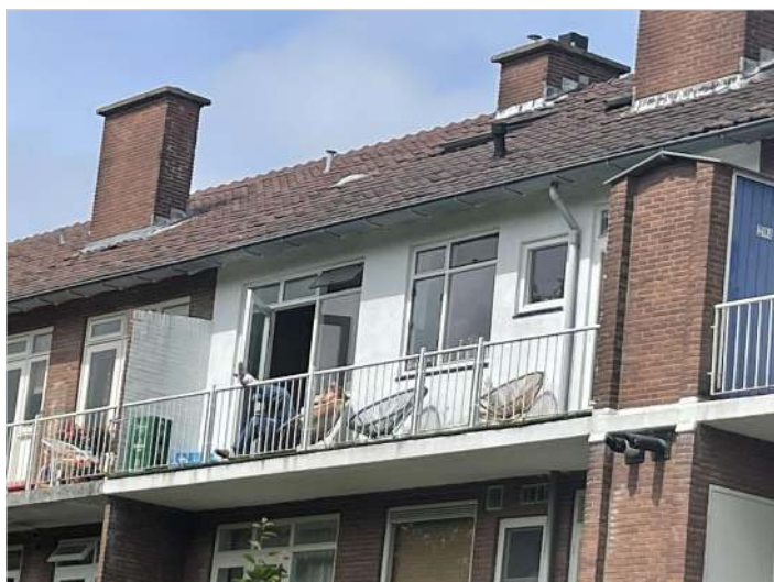
Situatie 21 mei 2026 achterzijde
