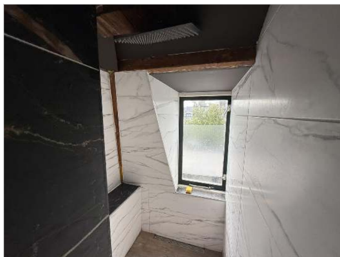
Badkamer eerste verdieping
